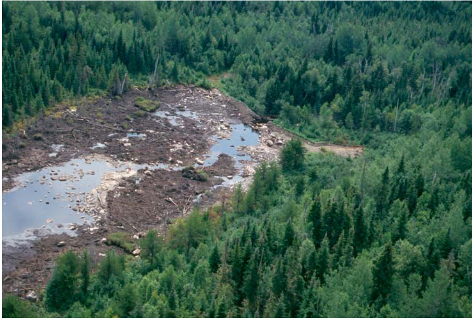
Figure 5. Étang récemment vidé à cause de la rupture du barrage, dans les Laurentides (Photo : André Robitaille)
